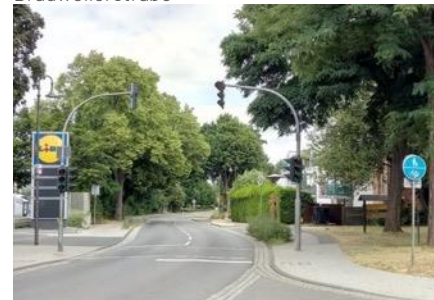
Abbildung: Zu schmaler Geh-/Radweg an der Brauweilerstraße
